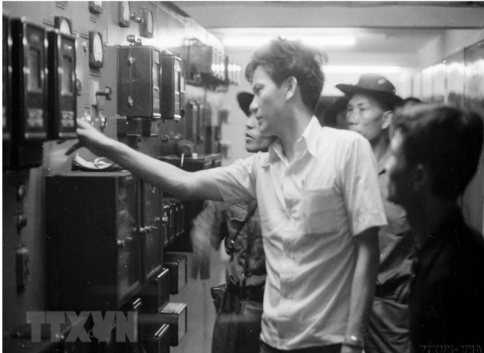
Hình. Công nhân nhà máy điện Chợ Quán (Sài Gòn) trở lại làm việc để cung cấp điện cho sản xuất và đời sống nhân dân thành phố (1975). (nguồn: Thông tấn xã Việt Nam)
